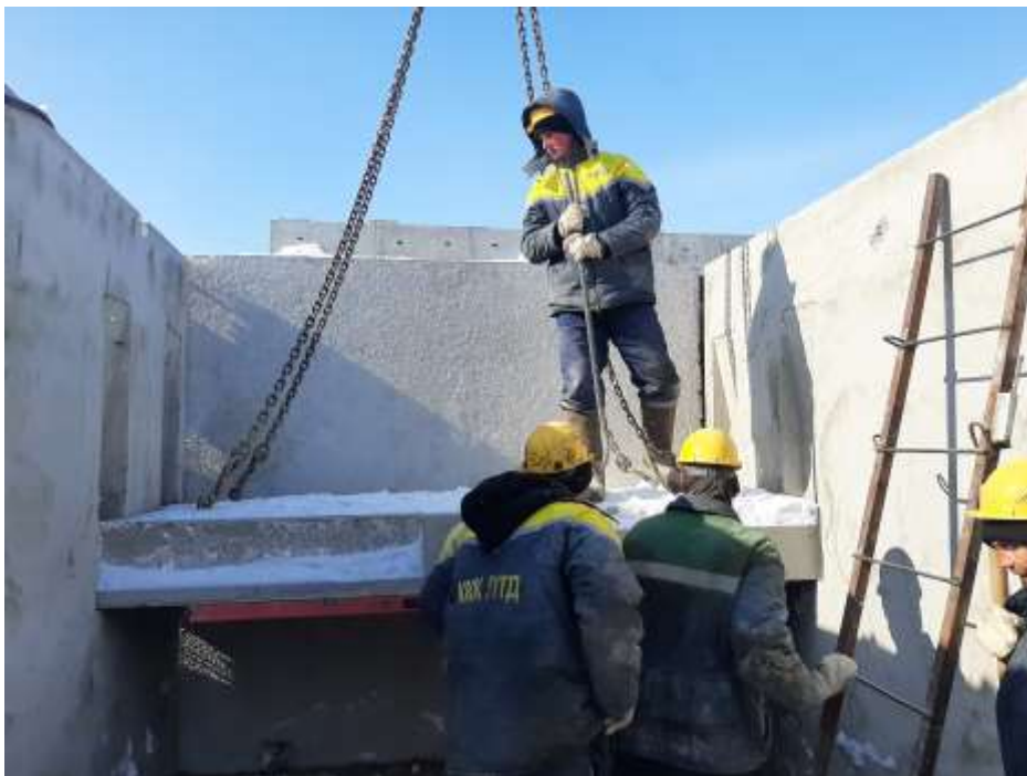
Рисунок 7 - Установка лестничной площадки
