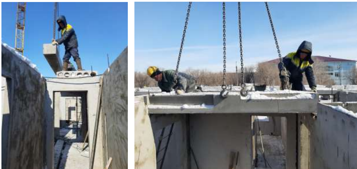
Рисунок 6 - Установка лестничных балок
